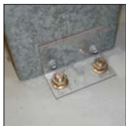
Крепление самонесущих конструкций
