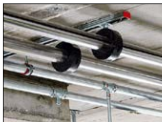
Крепление инженерных сетей
