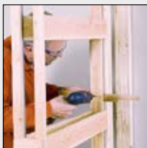
Крепление направляющих для лёгких конструкций
