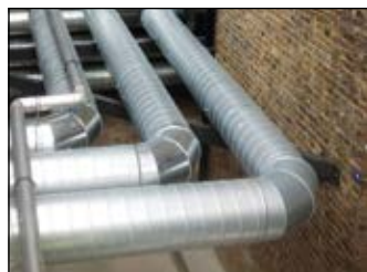
Крепление трубопроводов, воздухопроводов, электрики
