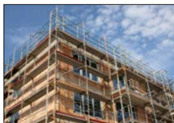
Монтаж строительных лесов
